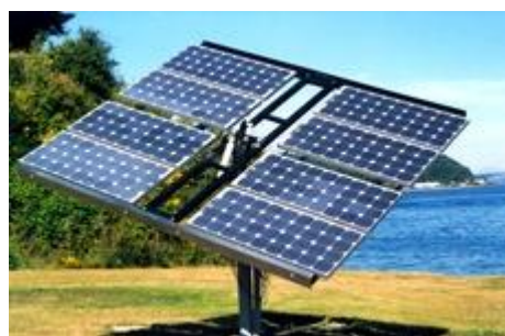
Слика3. ФВ со систем за следење
