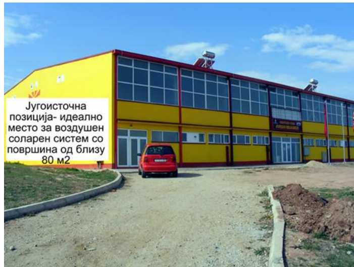
Слика 4. Локација за инсталација на воздушни колектори
