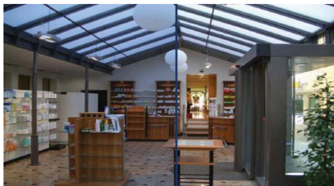
Слика 5. Покрив од аерогел во аптека во Швајцарија
