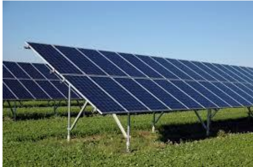
Слика3. Земјена инсталација на ФВ-систем
