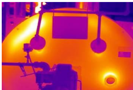
Слика 9 Загуба на топлина кај котел поради недоволна изолација
