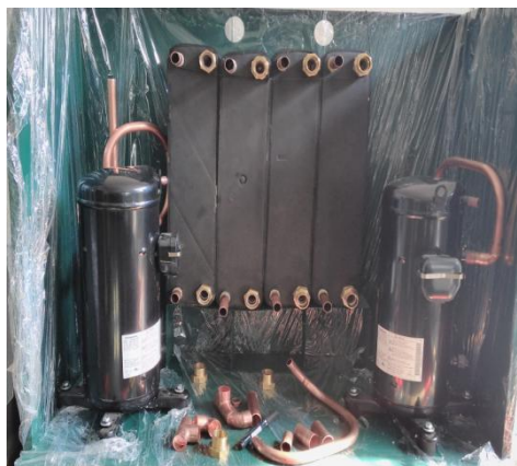
Слика 2. Приказ на внатрешноста на куќиштето на геотермална пумпа со 4 топлински разменуваачи
