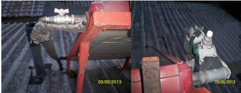
Слика 2. Отсуство на механичка заштита за цевен развод и автоматско лонче за воздух
