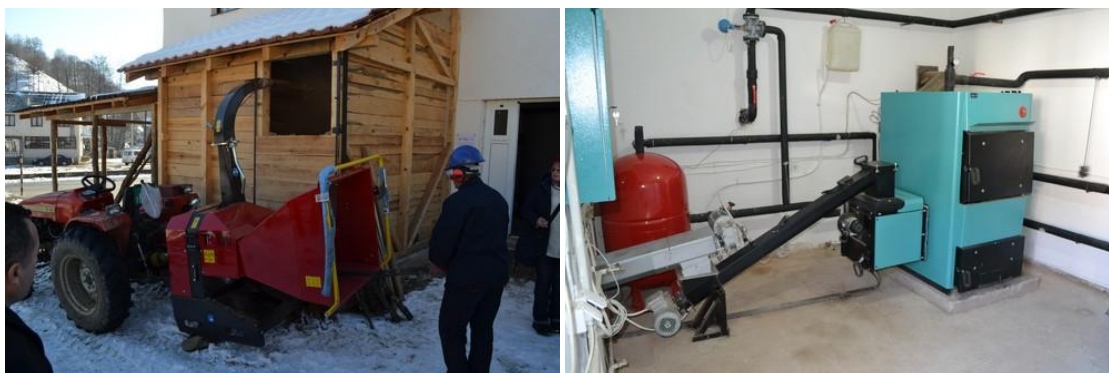
Слика 2. Машина за дробење на дрвната биомаса и котел (во посебна адаптирана просторија) со целокупна придружна опрема
