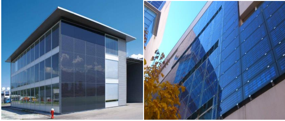
Сл. 5 Фасадни фотоволтаични системи
